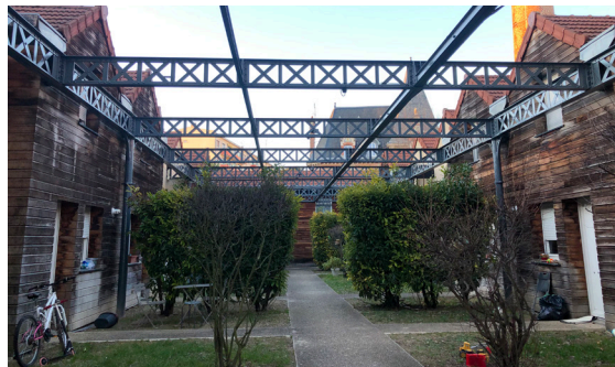
Réaménagement d'une friche industrielle à Troyes.
